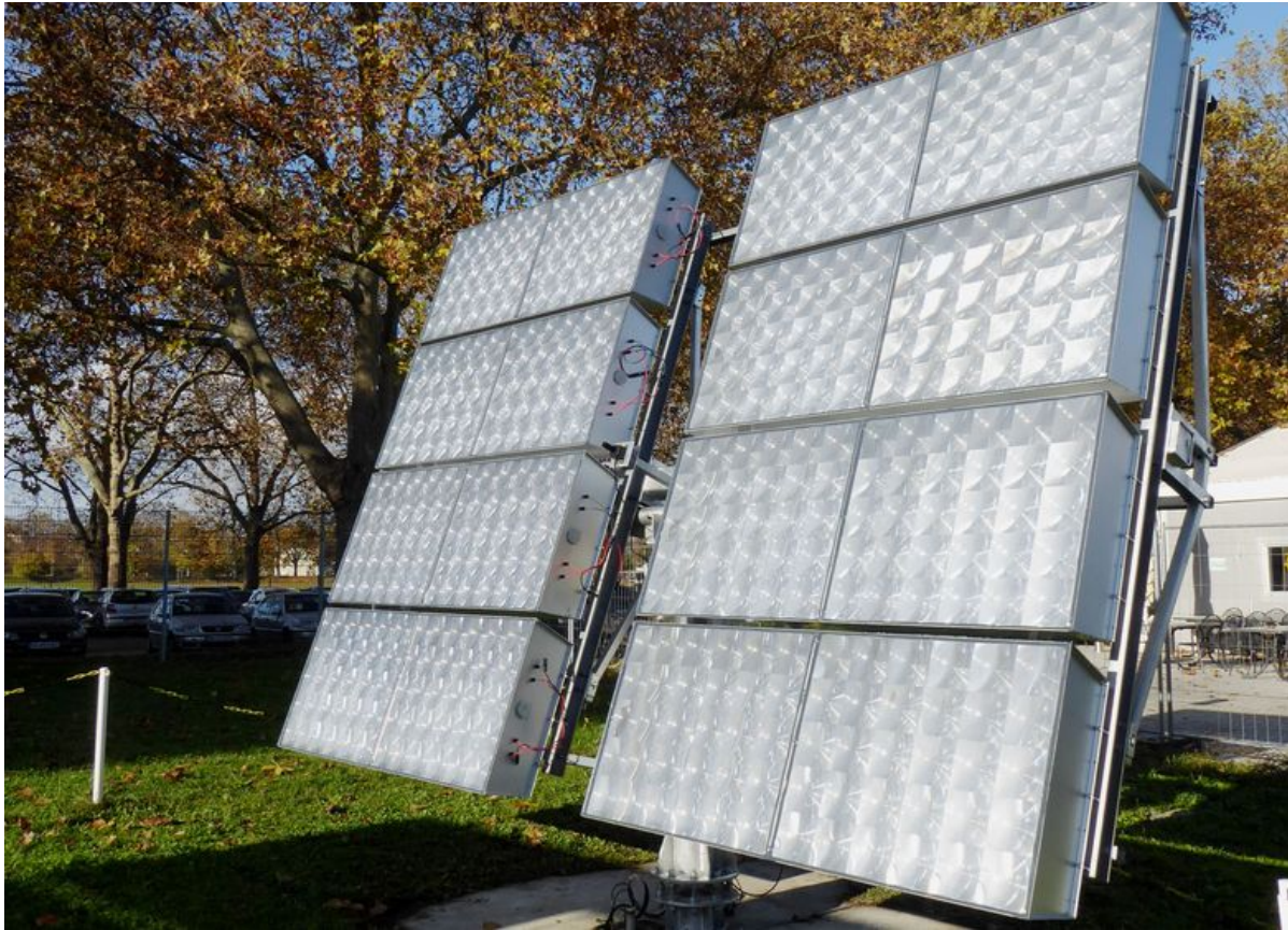
Konzentrator-Photovoltaik-Module fertig installiert auf einer zweiachsigen Nachführeinheit (Tracker) in Heilbronn.
