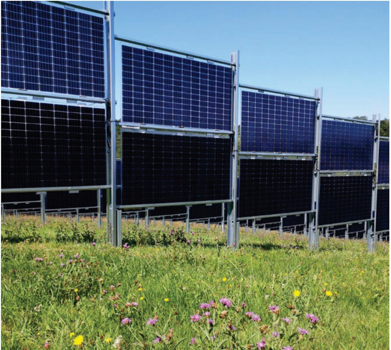
Abbildung 39: Vertikale PV-Modulreihe am Hang
