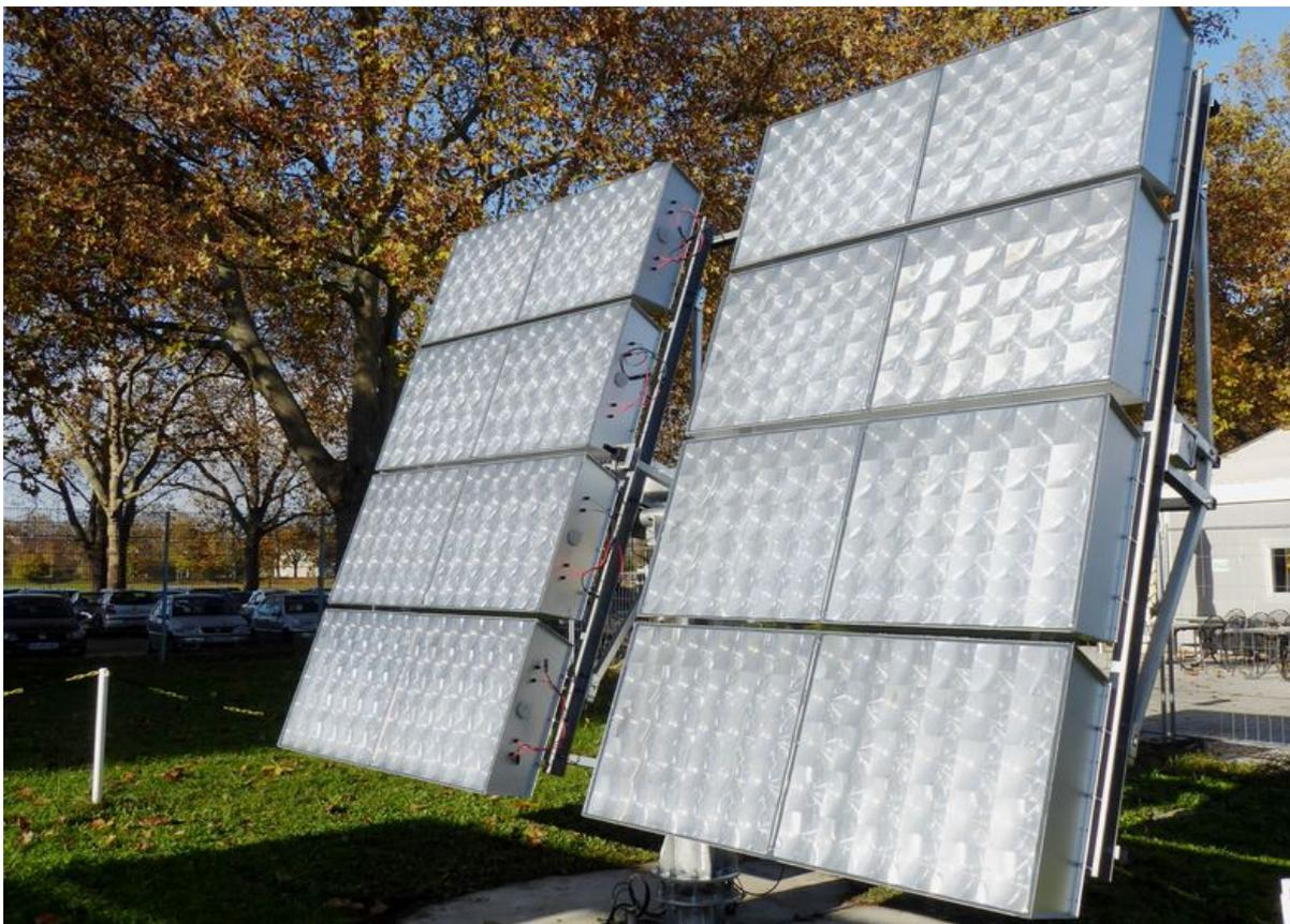
Konzentrator-Photovoltaik-Module fertig installiert auf einer zweiachsigen Nachführeinheit (Tracker) in Heilbronn.
