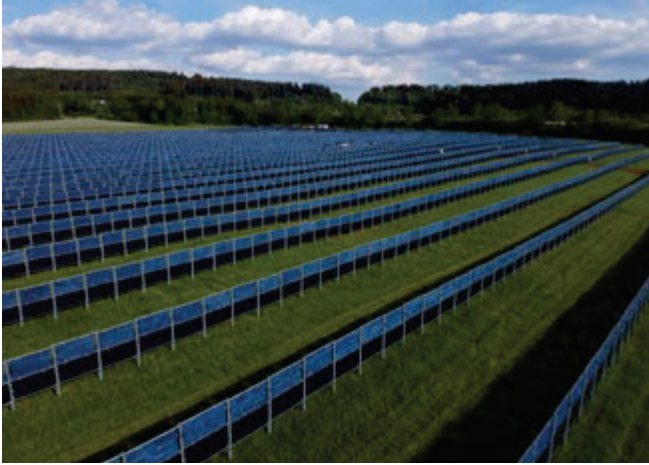
Abbildung 9: APV-Pilotanlage in Donaueschingen
