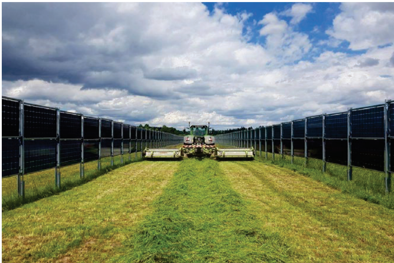
Abbildung 26: Die Reihenabstände sollten auf die nötigen Arbeitsbreiten der landwirtschaftlichen Maschinen abgestimmt werden
