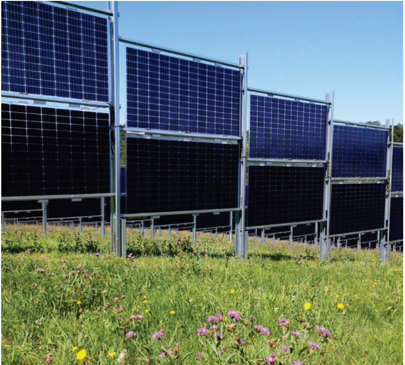
Abbildung 39: Vertikale PV-Modulreihe am Hang
