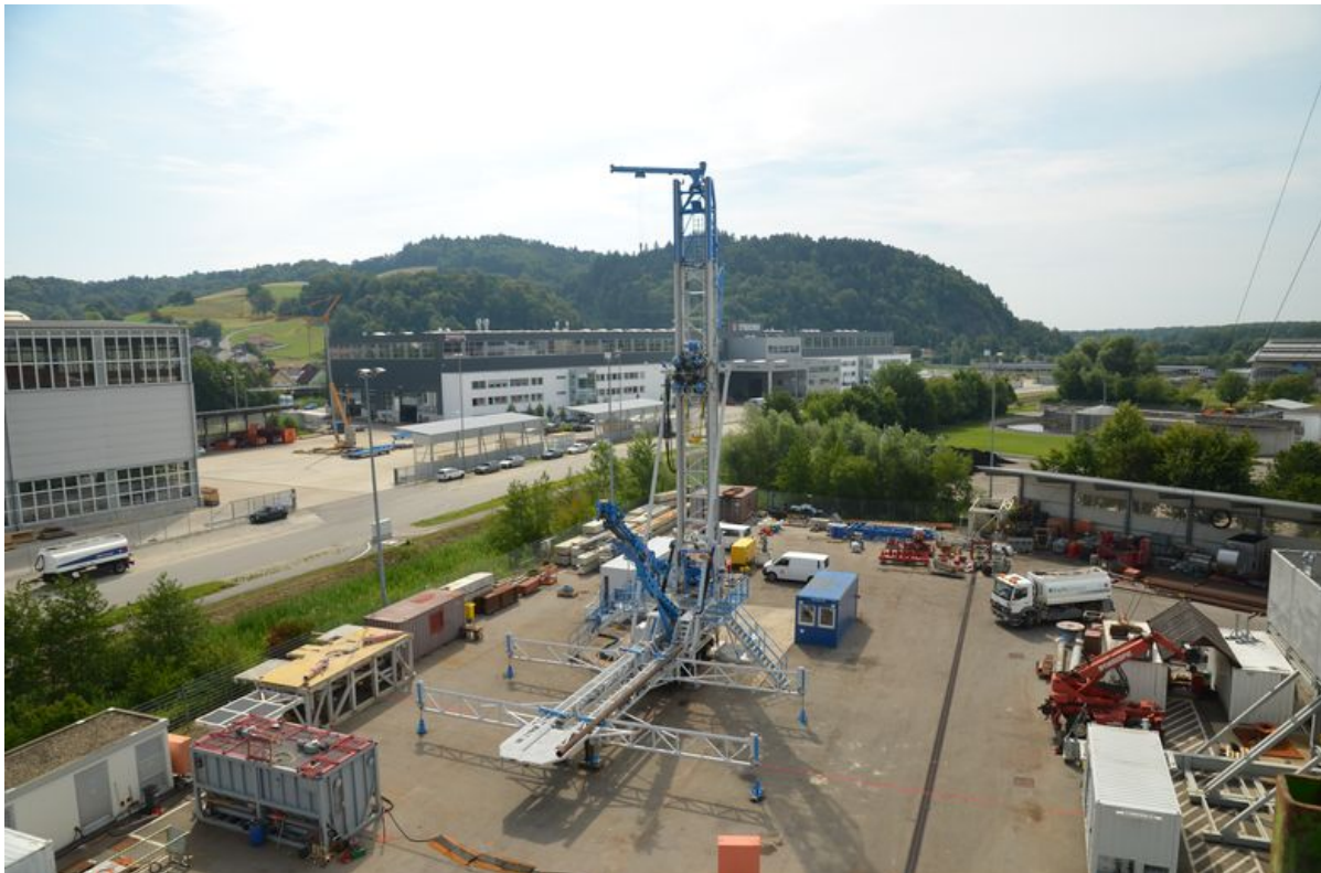
Workover-Anlage aufgebaut zum Testbetrieb
