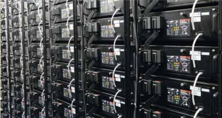
Abb. 2 Die Lithium-Ionen-Akkus befinden sich in standardisierten Industrie-Racks.
