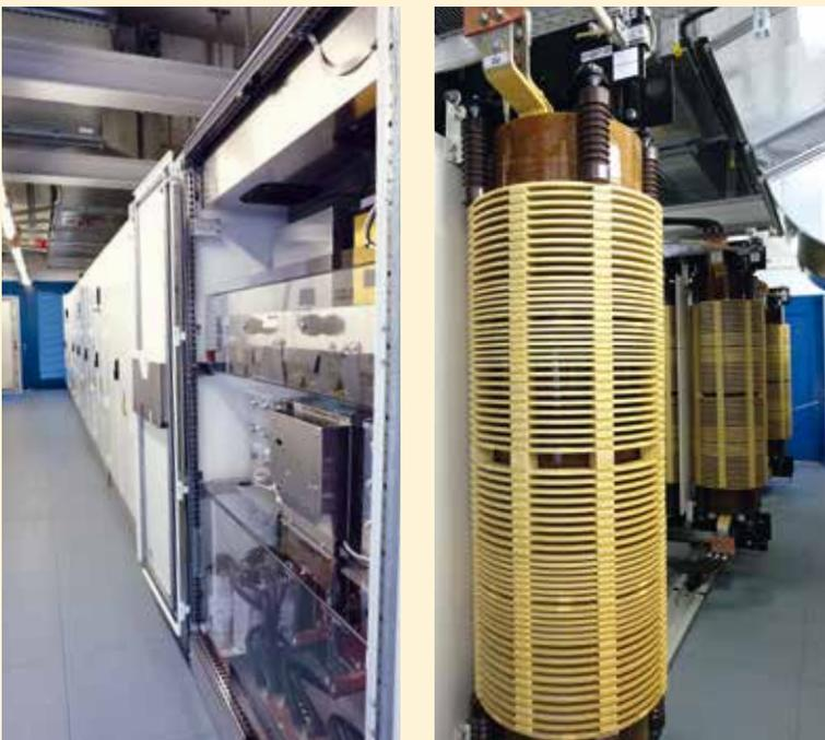
Abb. 3 Jeder Batteriestrang besitzt seinen eigenen Wechselrichter. Das Bürogebäude wurde statisch mit Doppel-T-Trägern verstärkt.
